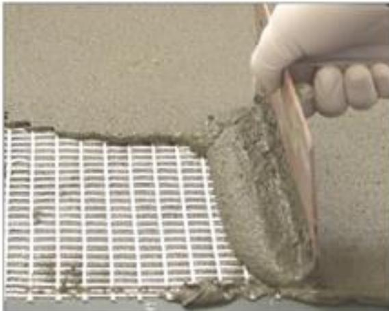
Schichtenweiser Aufbau im Laminierverfahren
