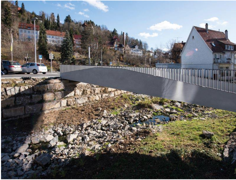
Fig.13: Fuß- und Radwegbrücke Albstadt-Ebingen. 2015. Erste, rein CF-bewehrte Betonbrücke der Welt mit CF-Textil soligrid Q95/95-CCE-38). First fully CF reinforced concrete bridge. [Knippers Helbig, für Solidian GmbH].
