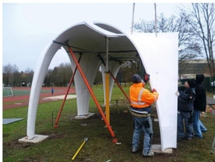
Fig.10: Links, Textilbetonpavillon mit Schalendicke 6 cm, 12 Lagen ungetränktes Carbondtextil, Abschlussdemonstrator des SFB 532, [Foto: Robert Mehl] und rechts Tragstruktur des T3 Pavillons, IfM RWTH Aachen. Left, TRC pavilion, wall thickness 6 cm, 12 layers dry CF textile; right, support structure of the T3 pavilion
