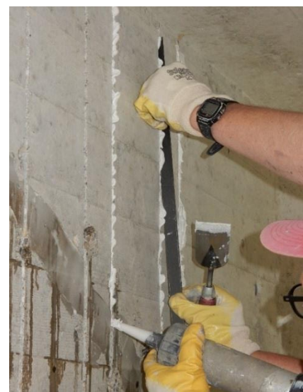
Fig.38: Ertüchtigung durch Zusatz-Schubbewehrung gegen Schrägriss im Steg durch in Schlitze geklebte CFK-Lamellen.
