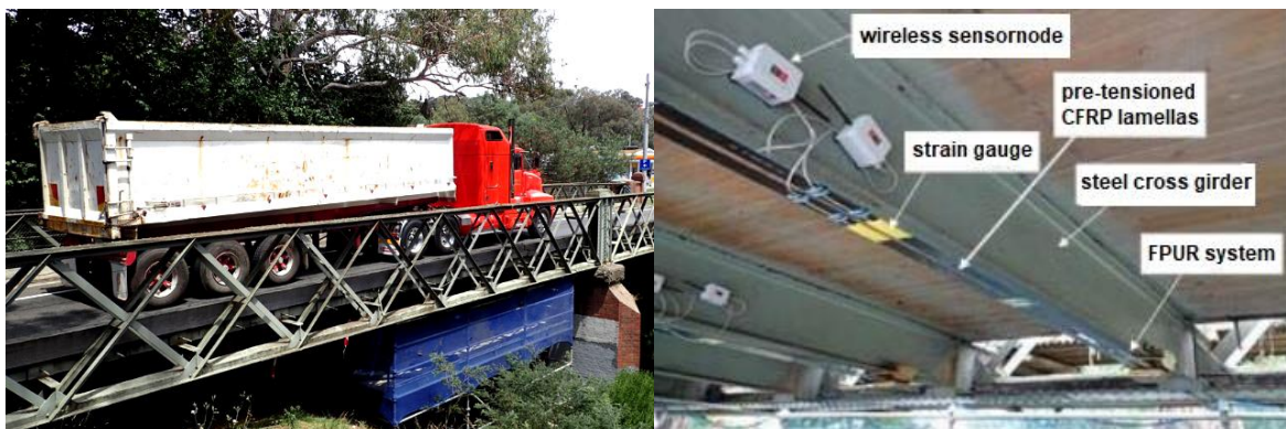
Fig.50: Rehabilitation durch endverankerte vorgespannte CFK-Lamellen (UD-Prepreg-Streifen von Rollen). 2
