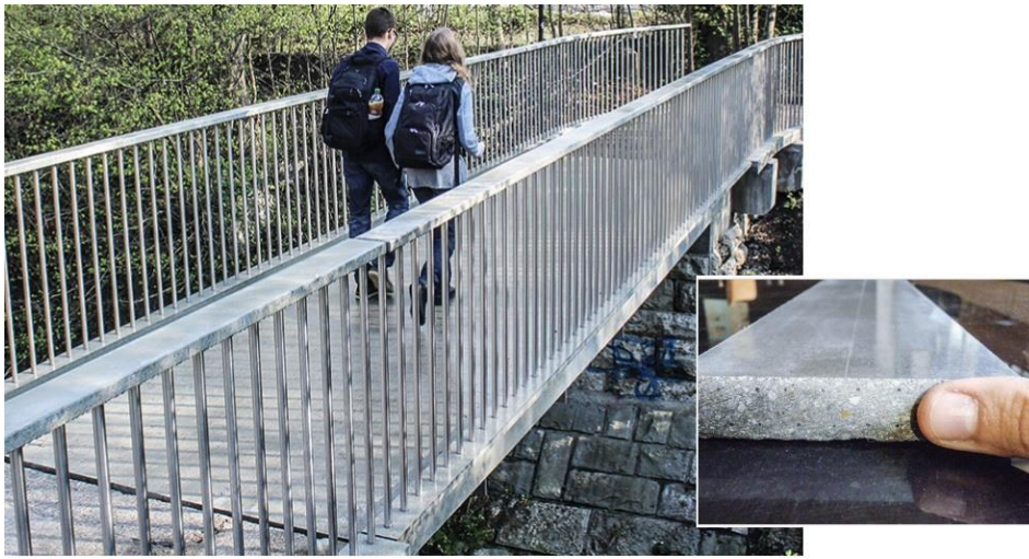
Fig.39: Brücke mit vorgespannten Deckplatten. Bridge with pre-tensioned slabs. ZHAW-bridge [J. Kurath].
