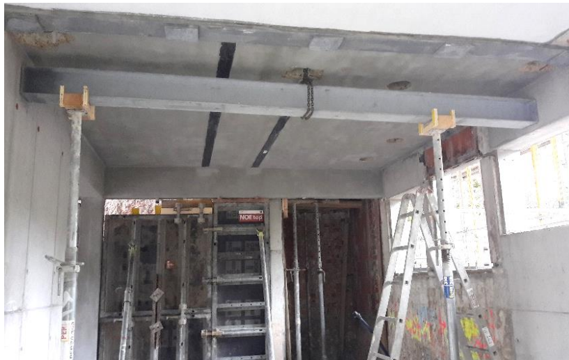
Fig.37: Verstärkung von Decken wegen erhöhter Feld- und Stützmente mit CFK-Lamellen 100 mm x 1,4 mm.
