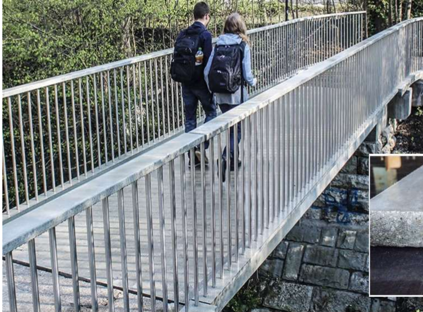
ZHAW-Brücke mit vorgespannten Deckplatten, Winterthur [J. Kurath]
