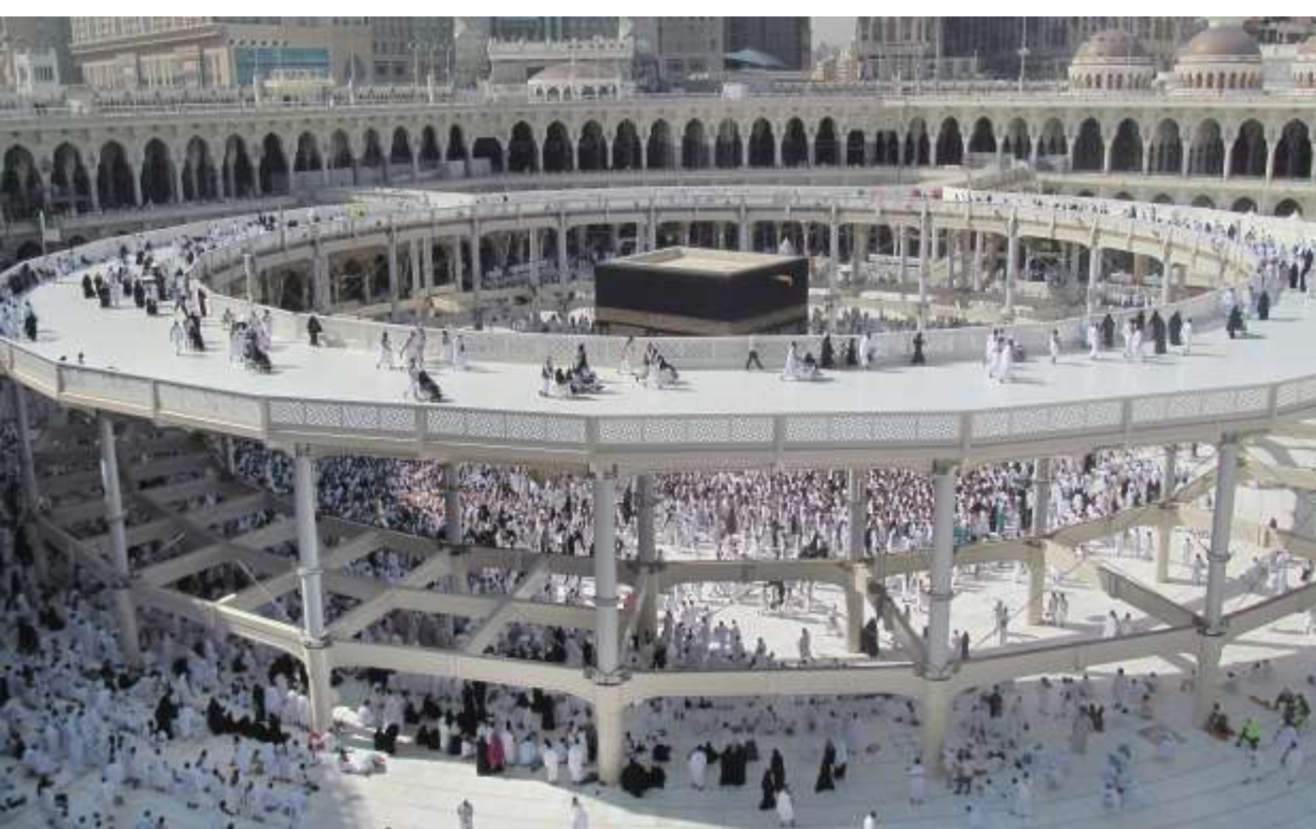
Mekka, CFK -Pilgerweg-Konstruktion um die Kaaba. Inner \Phi 80 m, 400 t CFRP [Premier Composite Technologie PCT, Dubai, VancouverSun.com ]
