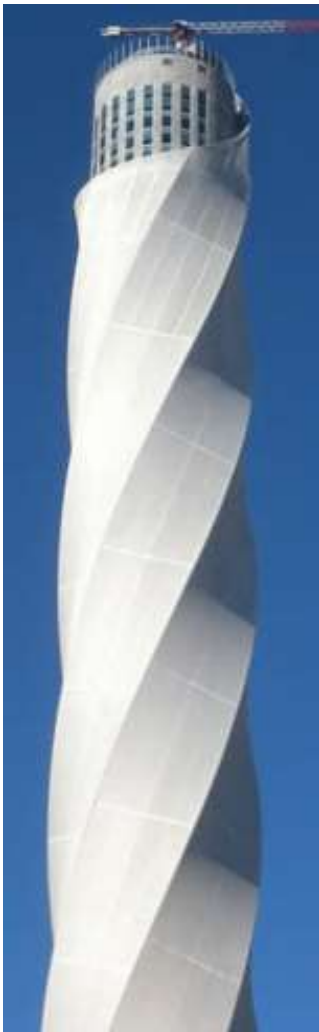
Test tower [Jahn/Sobek] querschwingungenvermeidende GF- Gewebe -Verkleidung des Thyssen-Krupp-Testturms für Hochgeschwindigkeitsaufzüge Rottweil, 245m, und der Prophetenmoschee, Medina SA,2010 [ILEK in cooperation with SL-Rasch]
