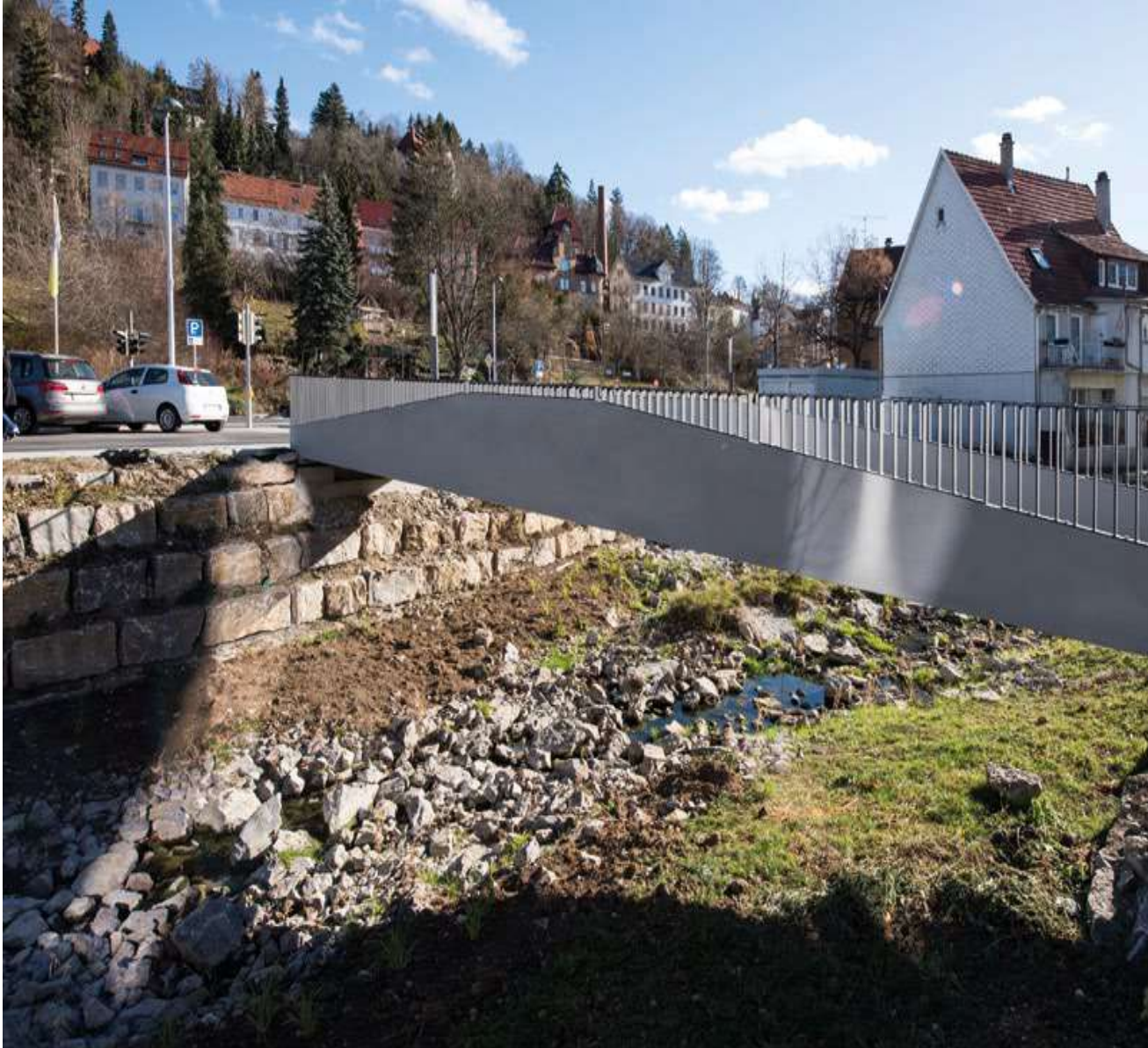
Erste, rein CF-bewehrte Betonbrücke der Welt. Albstadt-Ebingen. 2015, Solidian, soligrid Q-100-CEP-38 (Die Brücke rechnet sich laut Baubürgermeister Hollauer, und erst recht nachhaltig)
