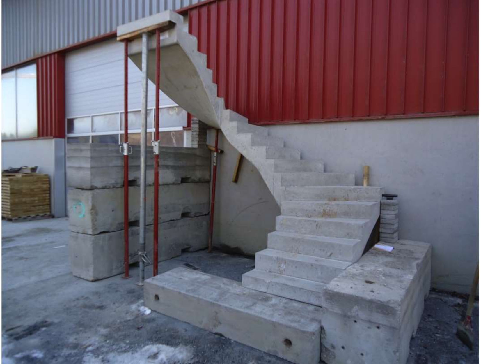
Stahl-Faserbeton-Fertigteiltreppe [B. Wietek]
