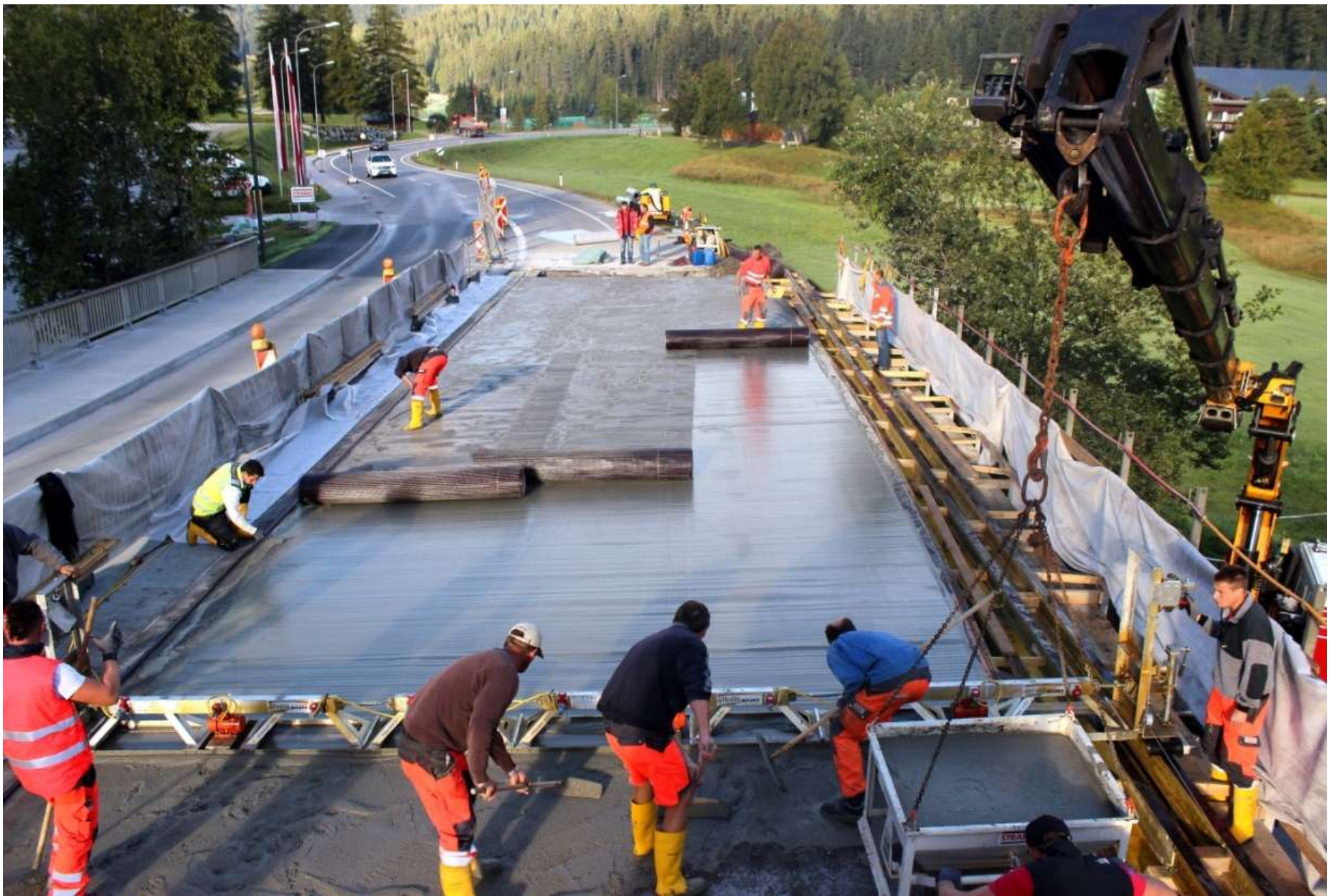
Brückendeckenplattenverstärkung, CF-Textil-Gitter , Aufbeton [Feix, Egger]
