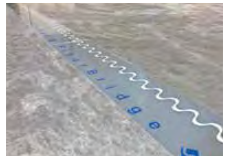
Bewegungsfugenprofil FloorBridge® WGX 20/50 für Industriebauten nach Fertigstellung
