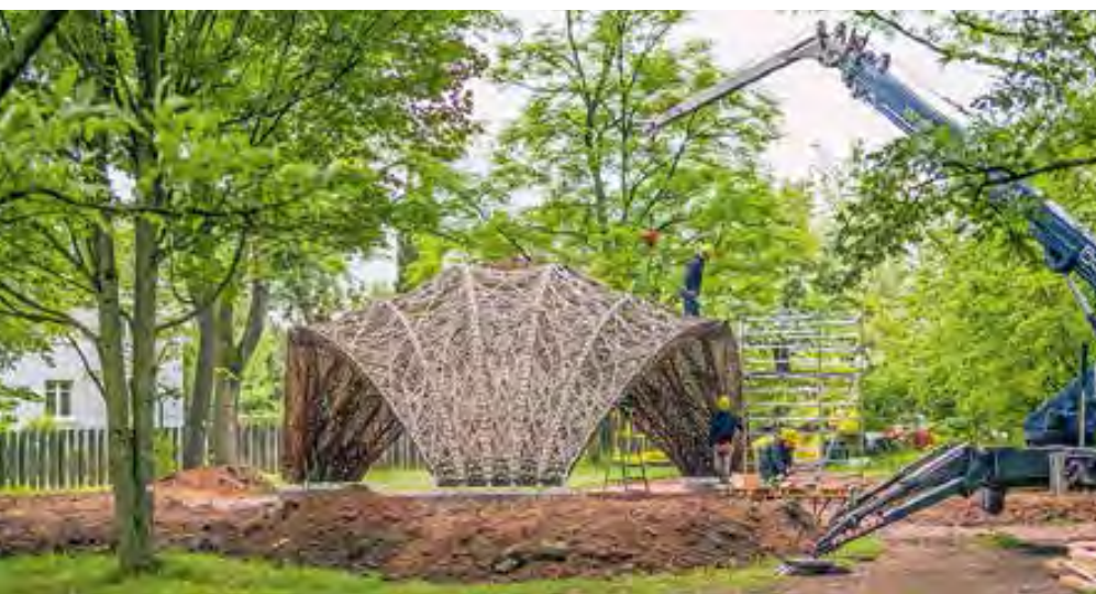
Rückzug aufgebaut: Die einzelnen Strukturelemente wiegen im Durchschnitt nur 105 kg
