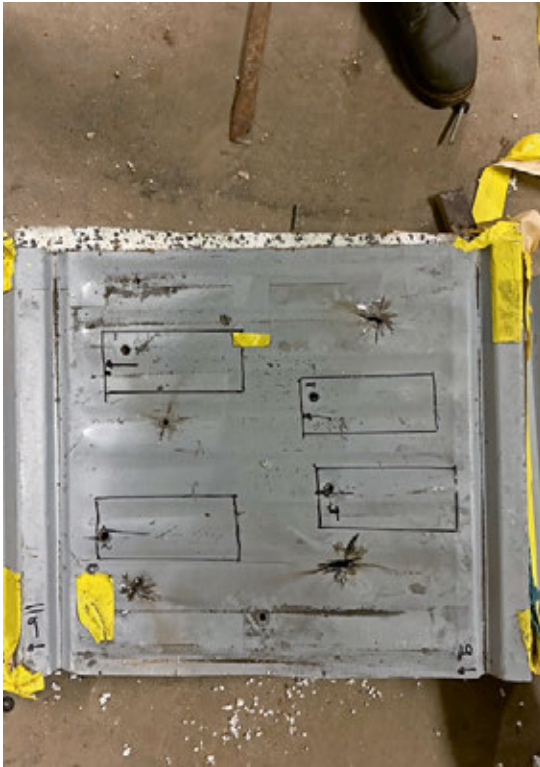
Trapezblech mit eingebrachten Bohrlöchern für die Bohrpacker (GelKo-Testbaustelle)
