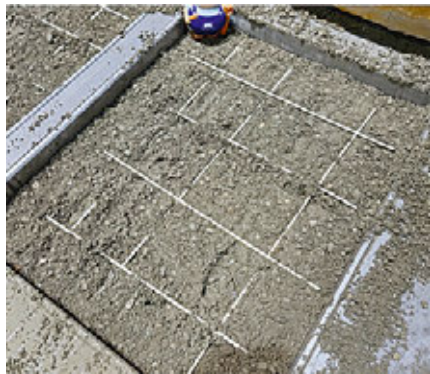
TEC-BAR Bewehrung in der Deckelplatte
