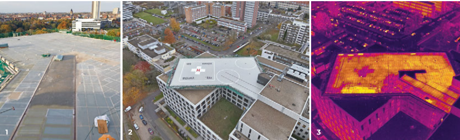
Hubschrauberlandeplatz ViDia Klinik Karlsruhe. 1: Verlegung der Heizelemente; 2: nach Fertigstellung mit Deckbeschichtung; 3: Thermoansicht
