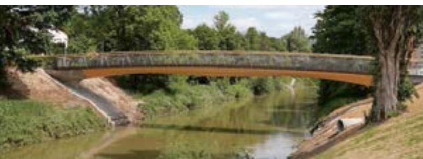
Filigrane Brücke aus Holz und Carbonbeton
