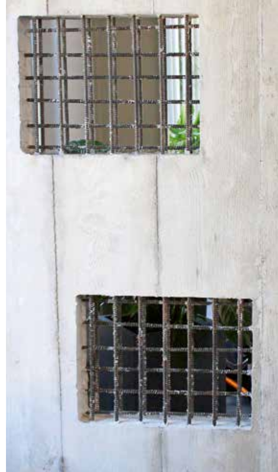
Weniger Zement, geringeres Gewicht, längere Lebensdauer – Beton mit nichtmetallischer Bewehrung © CG Tec GmbH
