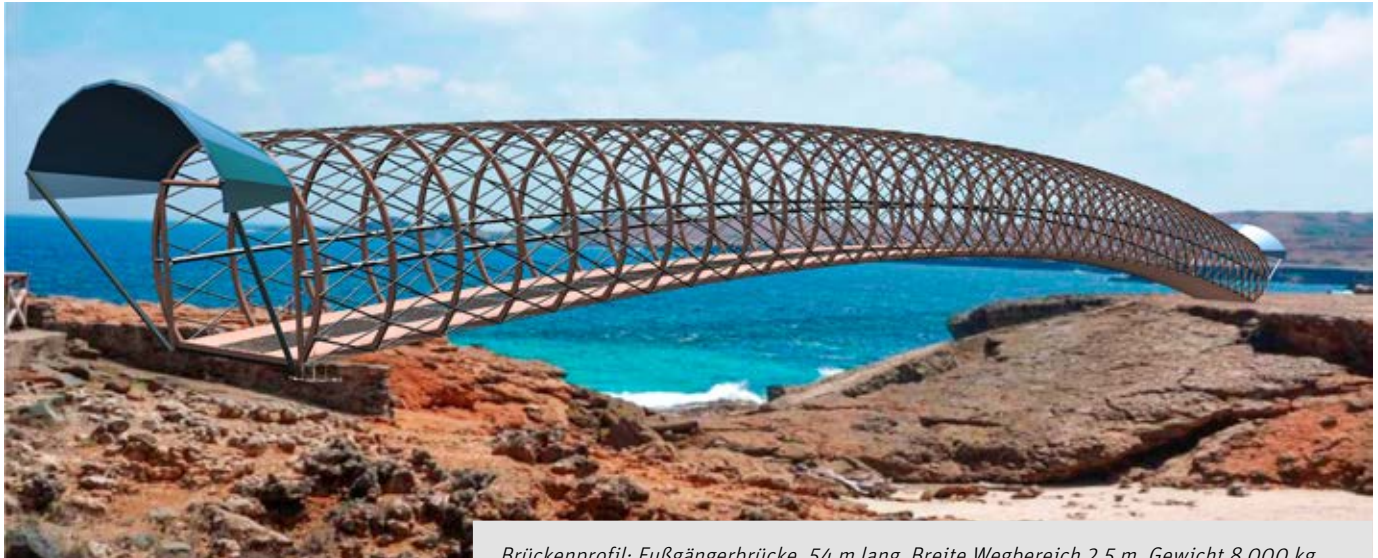
Brückenprofil: Fußgängerbrücke, 54 m lang, Breite Wegbereich 2,5 m, Gewicht 8.000 kg
