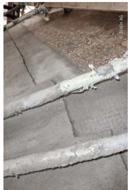
Carbonbewehrter Spritzmörtel und Textilbeton bewährten sich bestens bei der Sanierung des Mariendoms in Neviges
