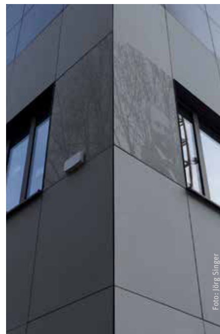
Bereits realisierte Carbonbeton-Fassade eines Gebäudes der TU Dresden
