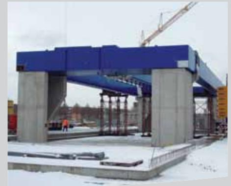
Bild 3: Dezember 2011 - Ungeachtet des Wintereinbruchs wird die Stahlrahmenkonstruktion noch vor Weihnachten montiert.
