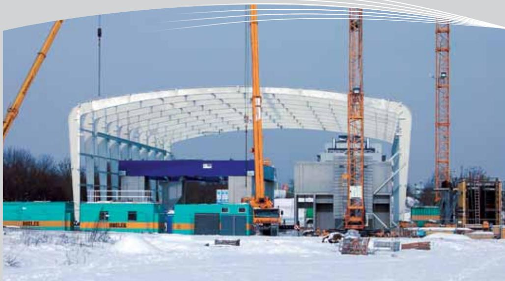
Bild 4: Januar 2012 - Die Stahlhülle steht.
