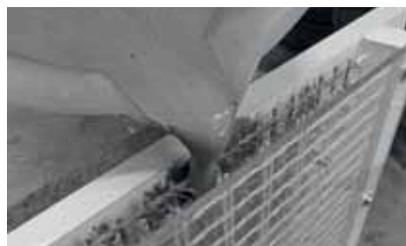
*Mit dem neuen Abstandshaltersystem DistTEX kann jetzt auch ein senkrecht Herstellungsverfahren umgesetzt werden, bei dem zwei schalglatte Seiten entstehen.*
