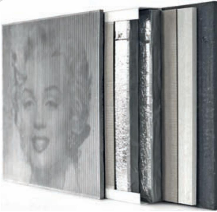
*Gestaltungsvariante eines modularisierten Textilbeton-Fassadenelements mit Kerndämmung*
