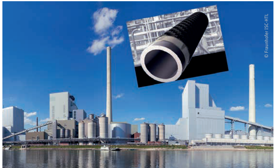
Hybridrohr aus Stahl und einem CMC-Mantel zum Einsatz als Druckleitung in Kraftwerken, hier im Großkraftwerk Mannheim
