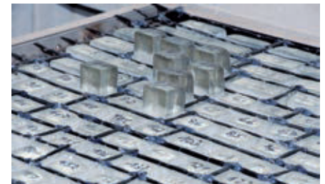
Abb. 3: Ansicht der Fenster vor der Betonage mit Carbonbewehrung
