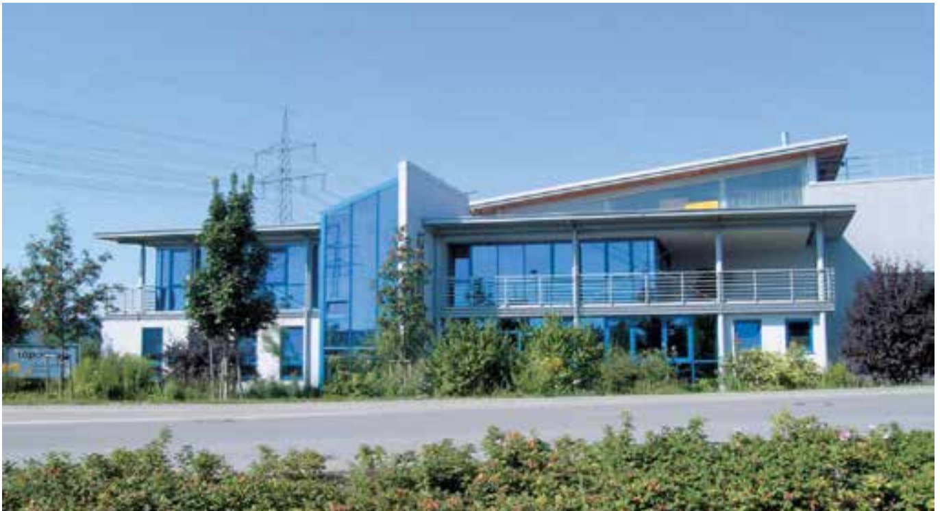
Firmengebäude der Topocrom GmbH, Stockach Topocrom GmbH building, Stockach
