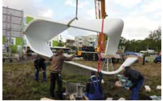
Abb. 8: Erstmalige Montage bei der IBA in Hamburg
