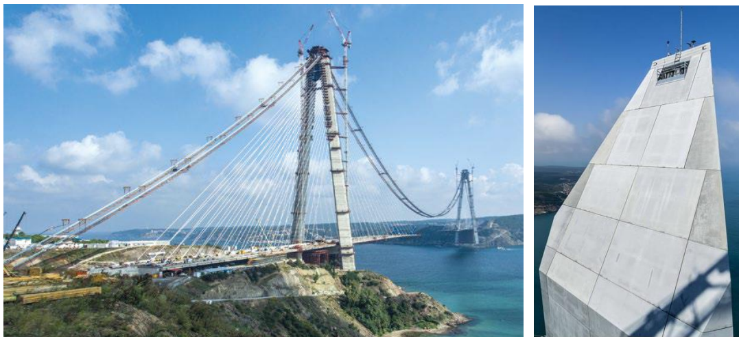
Fig.12: Bosphorusbrückenpfeiler, H=320 m.
