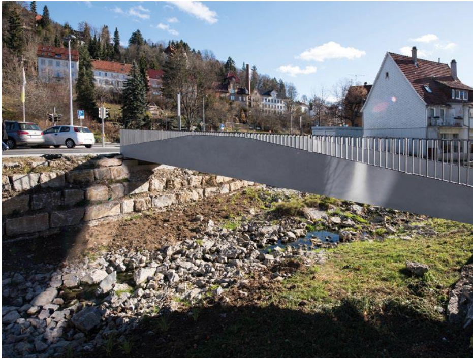
Fig.13: Fuß- und Radwegbrücke Albstadt-Ebingen. 2015. Erste, rein CF-bewehrte Betonbrücke der Welt mit CF-Textil soligrid Q95/95-CCE-38). First fully CF reinforced concrete bridge. [Knippers Helbig, für Solidian GmbH].
