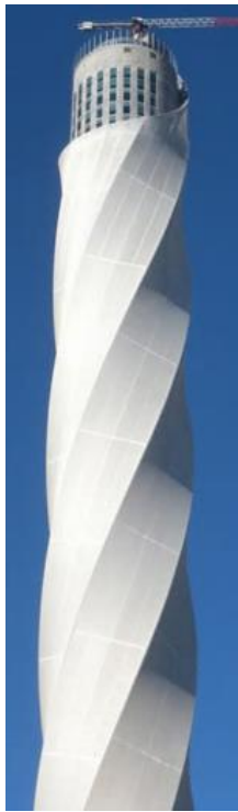
Fig.6: Left: querschwingungenvermeidende GF-Gewebe-Verkleidung des Thyssen-Krupp-Testturms für Hochgeschwindigkeitsaufzüge Rottweil, 245 m hoch. Test tower for high-speed lifts [ILEK, Jahn/Sobek] Right: Piazza-Überdachung, Prophetenmoschee, Medina SA, 2010. Canopy of the Piazza [ILEK with SL-Rasch]
