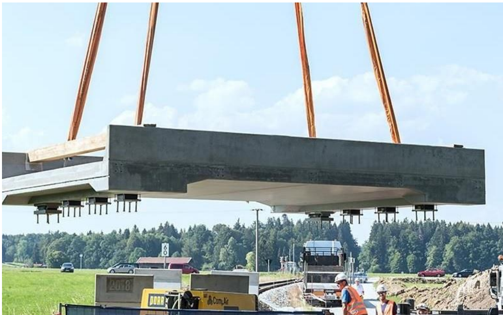
Fig.16: Vorgespannte UHPFRC-Eisenbahnbrücke bei Gmund Obb. C150/155 mit zusätzlicher 2,5% Mikro-Stahlfaserbewehrung. Pre-tensioned UHPFRC railway bridge with additional micro steel fiber reinforcement. [U. Benz, LfM TUM, Baufirma Max Bögl].
