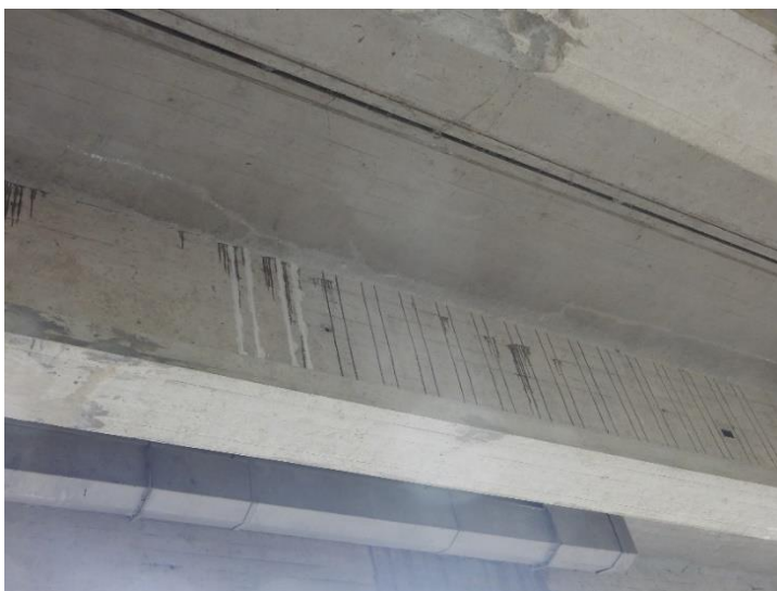
Fig.38: Ertüchtigung durch Zusatz-Schubbewehrung gegen Schrägriss im Steg durch in Schlitze geklebte CFK-Lamellen.
