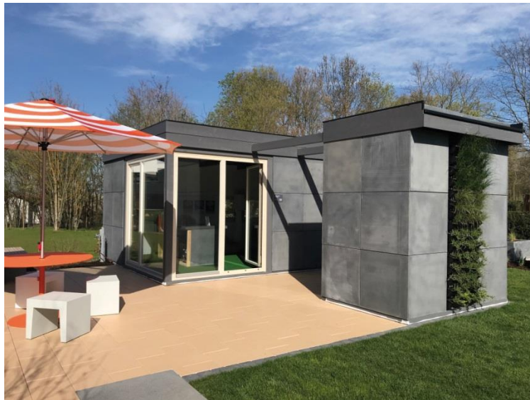
Fig.53: Verbundmodul-Bauweise aus Carbonbeton-Holzrahmenbau als leichte modulare, rückbaubare Fertigteilbauweise hoher Isolation, 20 mm UHPC-Außenschale inkl. Carbongitterbewehrung 96k-SITgrid. Composite module 'method of construction' of carbon concrete with wooden frame, UHPC outer shell reinforced. [betondesign factory, Schönborn].
