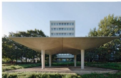
Fig.10: Links, Textilbetonpavillon mit Schalendicke 6 cm, 12 Lagen ungetränktes Carbontextil, Abschlussdemonstrator des SFB 532, [Foto: Robert Mehl] und rechts Tragstruktur des T3 Pavillons, IfM RWTH Aachen. Left, TRC pavilion, wall thickness 6 cm, 12 layers dry CF textile; right, support structure of the T3 pavilion
