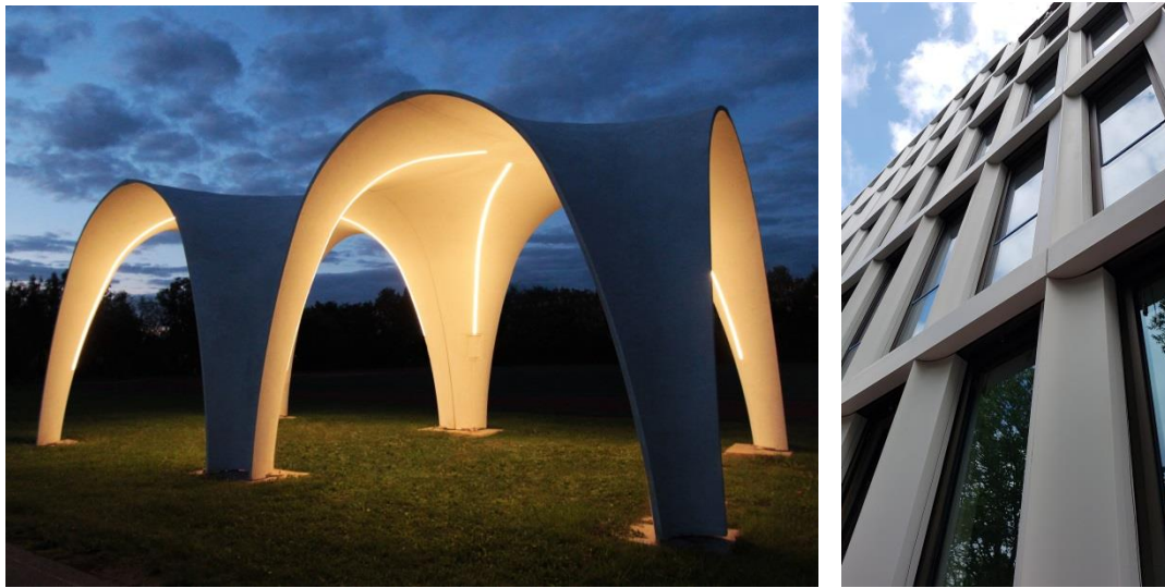
Fig.11: (links) Integrativer Carbonbeton-Pavillon, Betonschalen aus hochfestem ‘Feinbeton‘ mit textiler Carbonbewehrung, integrierter LED-Beleuchtung und induktiven Sensoren zur Steuerung der Lichtszenarien; (rechts) Neubau Kaiser-Wilhelm-Hof, Köln mit freigeformten dünnwandigen Fassadenelementen aus GFK-Architekturbeton hoher Oberflächenqualität, exzellenter Dauerhaftigkeit, mechanischer Eigenschaften [TU Chemnitz].
