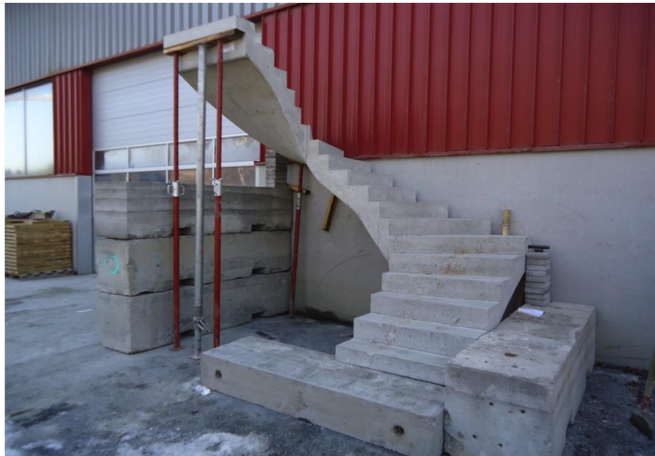
Fig.40: Fertigteiltreppe aus Faserbeton FB. Precast stairs made of fiber-reinforced concrete FRC. [B. Wietek].
