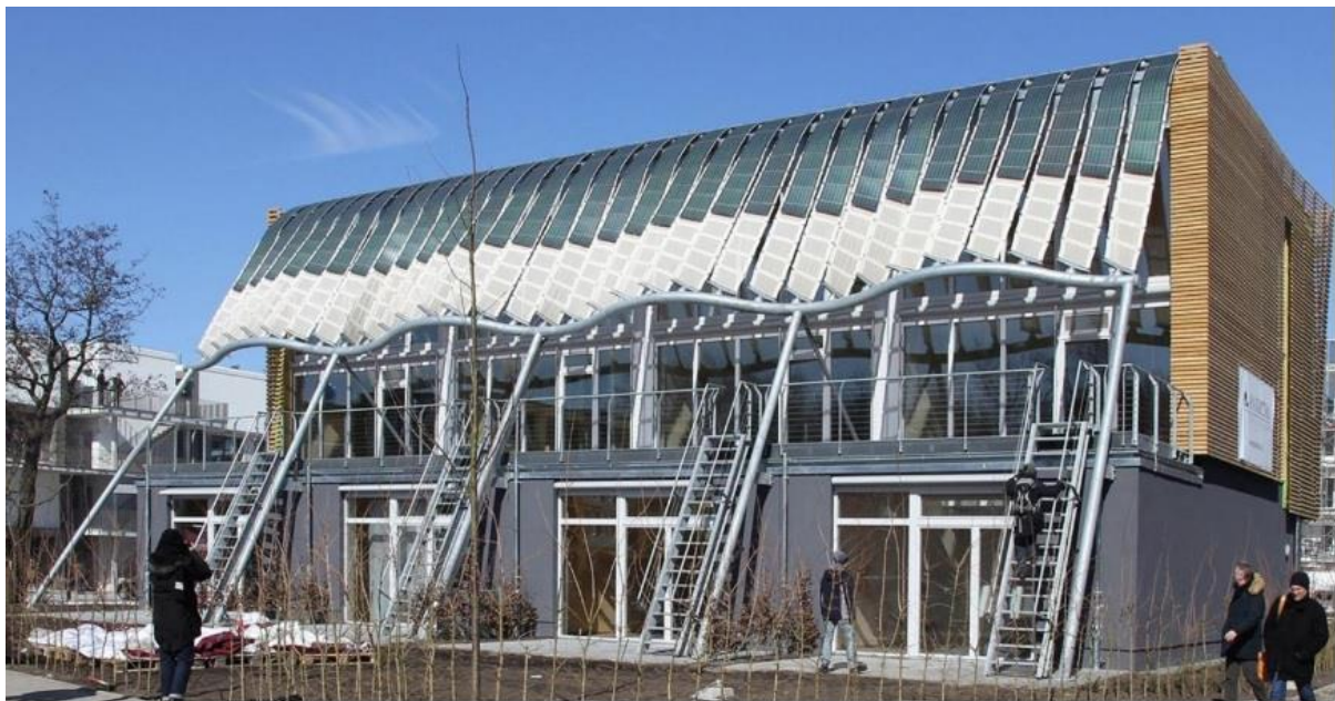
Fig.7: Pultrudierte Flachprofile als große 'Federelemente' für die Regelung der Membranstreifen des Verschattungssystems.
