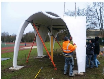
Fig.10: Links, Textilbetonpavillon mit Schalendicke 6 cm, 12 Lagen ungetränktes Carbontextil, Abschlussdemonstrator des SFB 532, [Foto: Robert Mehl] und rechts Tragstruktur des T3 Pavillons, IfM RWTH Aachen. Left, TRC pavilion, wall thickness 6 cm, 12 layers dry CF textile; right, support structure of the T3 pavilion
