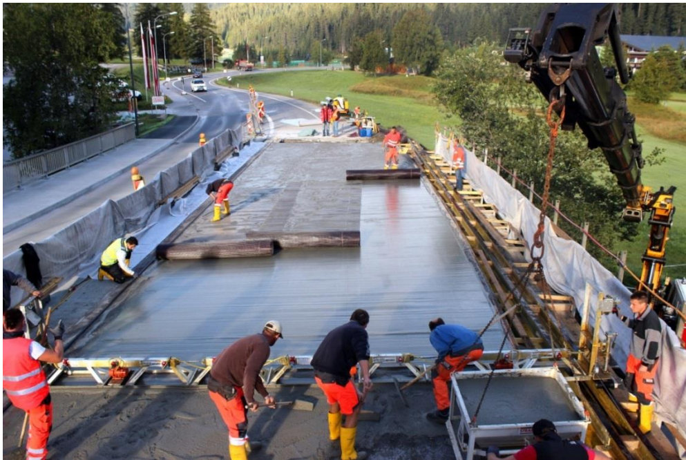
Fig.14: Rehabilitation: Brückendeckenplatte durch Carbonbeton-Aufbeton. Rehabilitation: bridge deck plate by carbon concrete topping. [J. Feix, M. Egger. Lehrstuhl Massivbau und Brückenbau, Uni Innsbruck]
