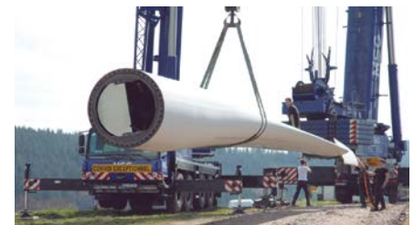
Abb. 1: Rotorblatt beim Rückbau einer Windkraftanlage
